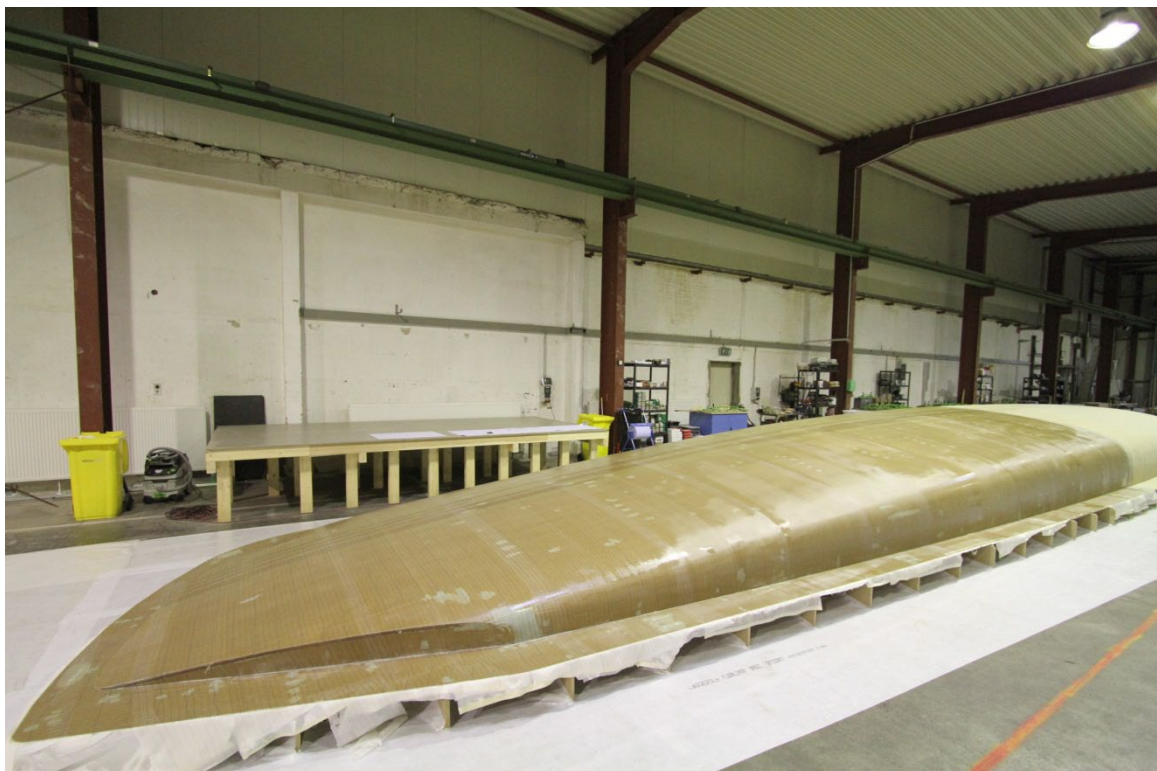
Hier: während der porenfüllenden und besonders schrumpfarmen Beschichtung mittels Epoxidharz und Glasgeweben
